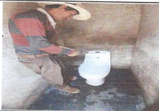
Foto 3: Avance de sustitución de Deposito
