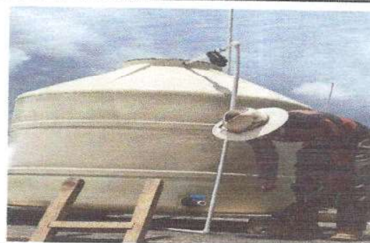
Foto 4: Avance de Sustitucion de Inodoro
