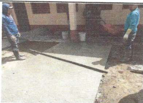
Foto 5: Avance de la sustitucion de piso de torta de concreto de 8 cm de espesor
