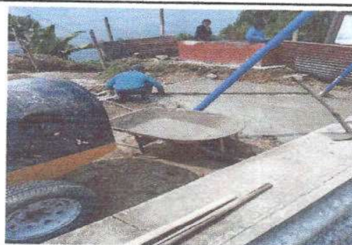
Foto 6: Avance de la sustitucion de piso de torta de concreto de 8 cm de espesor
