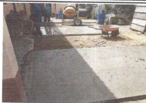
Foto 2: Avance de la sustitución de piso de torta de concreto de 8 cm de espesor
