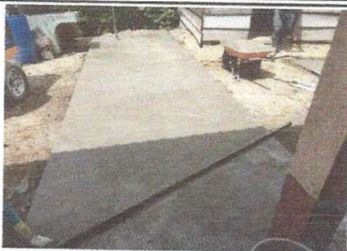
Foto 1: Avance de la sustitución de piso de torta de concreto de 8 cm de espesor
